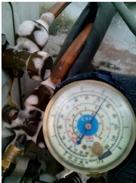
Apabila tiub kuprum siap dipasang pada indoor dan outdoor, maka lakukan proses *air purging*. Proses ini bertujuan untuk menguji kebocoran dan membuang lembapan dalam tiub kuprum. Ujian kebocoran dibuat dengan menggunakan buih sabun pada sambungan *flaring*.
