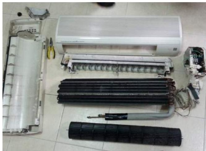
Berhati-hati semasa menanggalkan semua komponen terlibat. Asingkan motor *blower*, komponen elektronik dan *indoor sensor*. Komponen – komponen ini diservis berasingan. Pastikan hujung penyejat ditutup dengan *wiring tape* untuk mengelak dari lembapan dan habuk masuk.
