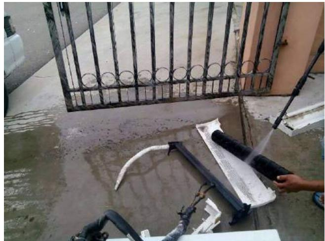
Sembur dengan pancutan air dari waterjet dari kiri ke kanan selari dengan arah bilah blower. Lihat kotoran pada blower sebelum di servis.
