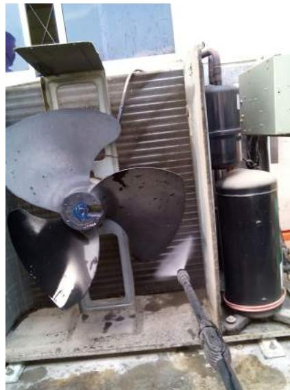
Sembur dengan pancutan air dari waterjet dari atas ke bawah selari dengan arah sirip pemeluwap. Pastikan bahagian pemampat dan komponen elektronik telah ditutup dengan plastik.
